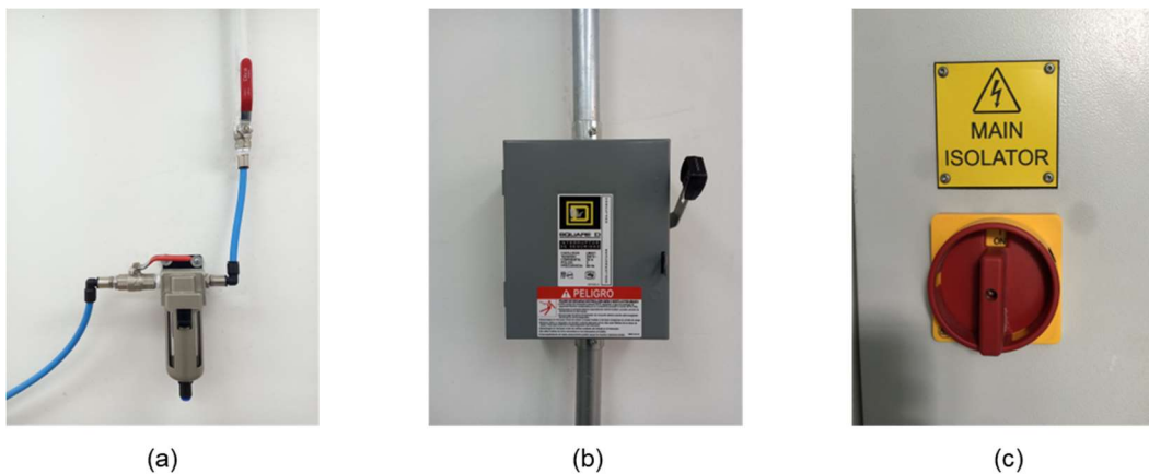
Figura 3. Pasos para el encendido de la máquina, (a) Llave de paso para el aire del compresor, (b) Interruptor de corriente eléctrica y (c) Perilla de encendido y apagado de la máquina CNC.
