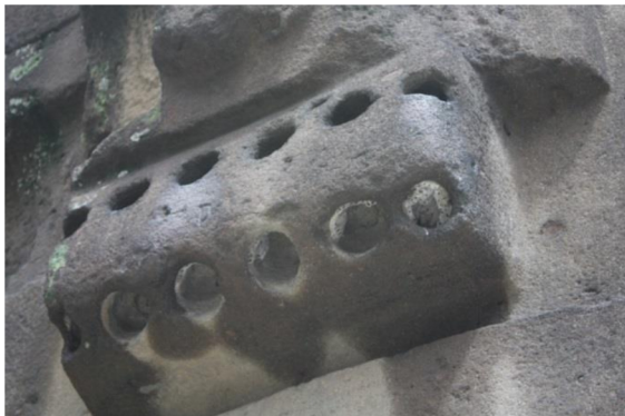
Figura1.11. A causa de los encharcamientos y escurrimientos hay zonas del monolito que retienen humedad.
