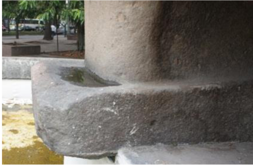
Figura 1.32. Encharcamiento de agua en el pie derecho de la escultura.
