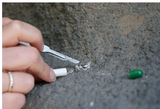
Figura 1.17. Deyección de ave en el pie derecho.
