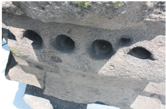
Figura 1.12. Frentes de secado en las cavidades de la “boca” de la escultura que denotan la acumulación de agua de lluvia.
