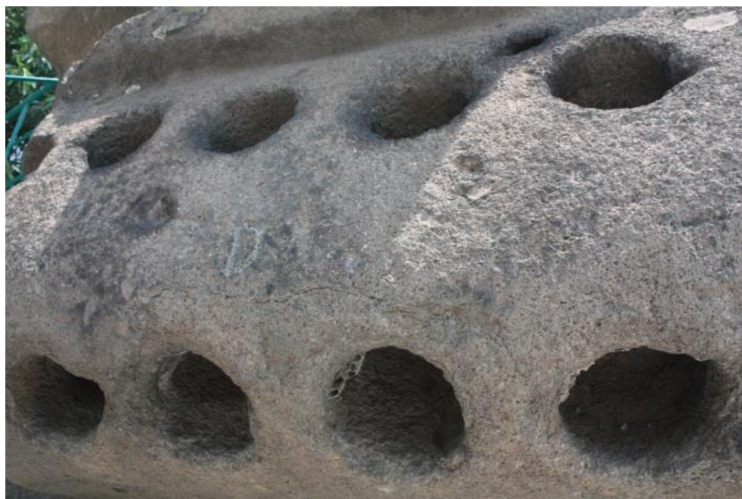
Figura 1.8. Fisura con mayor riesgo estructural.
