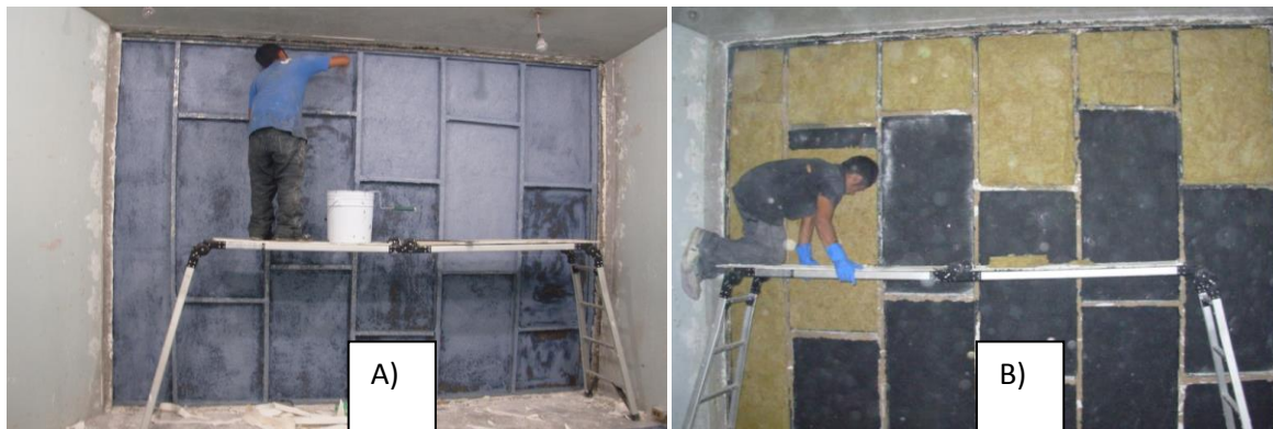
Figura 12. Colocando A) pintura acústica B) lana mineral
