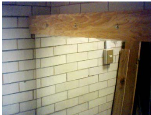
Figura 6. Cajas de madera para alojar los extremos del espejo deformable
