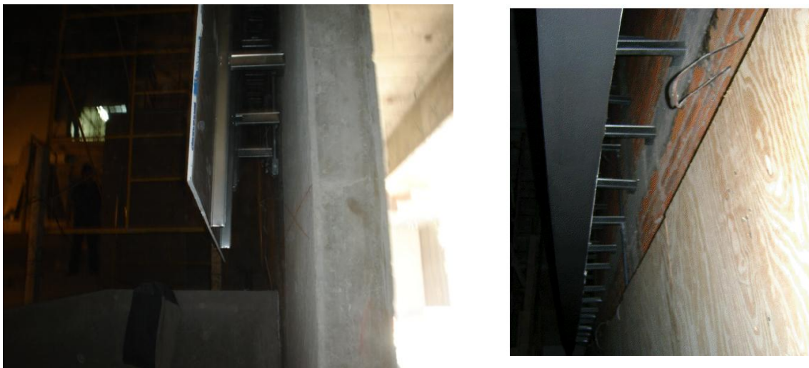
Figura 1.- Montaje utilizado para la colocación del plafón.
