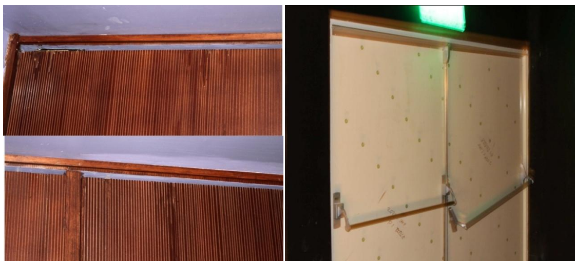
Figura 2.- a) Detalle del exterior de las puertas de acceso a las salas cinematográficas, donde se puede observar las ondulaciones en la superficie que impiden el sello perimetral de la puerta y b) Detalle de una puerta de emergencia.
